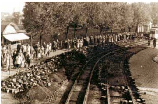
Umspurung – rechts liegt schon das neue Gleis
