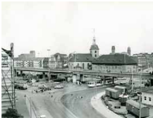
Bau Hochstraße und Kreuzung am Marientor 1971
