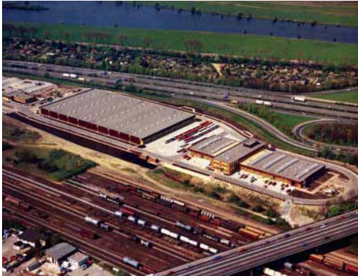
Betriebshof Am Unkelstein, zwischen A 59 (vorne) und A 40
