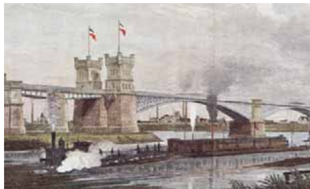
Hochfelder Eisenbahnbrücke 1874, daneben noch der alte Trajektverkehr
