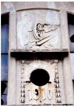
Detail vom 1999 abgerissenen Depot Hamborn am Schlachthof
