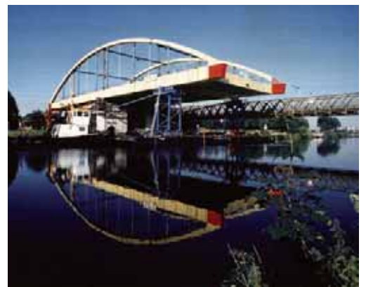
Montage der neuen Brücke, im Hintergrund die Behelfsbrücke
