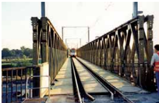
Behelfsbrücke für die Straßenbahn
